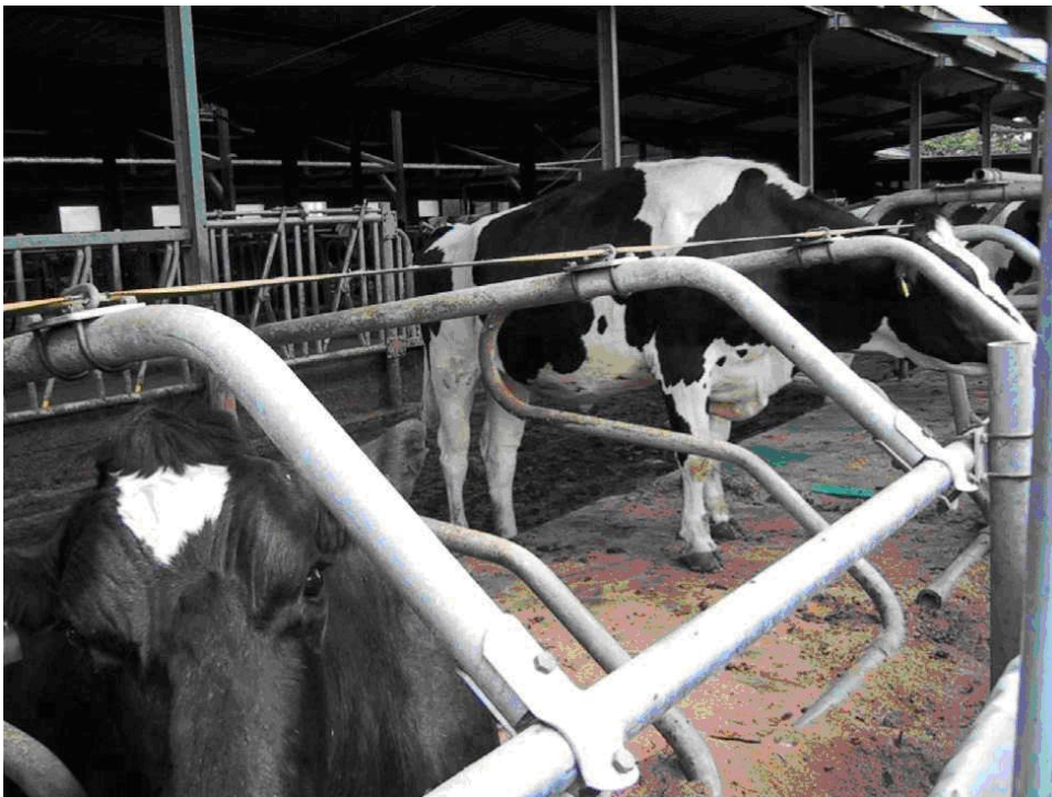
Фиг. 5. Объемна конструкция на боксов разделител .
